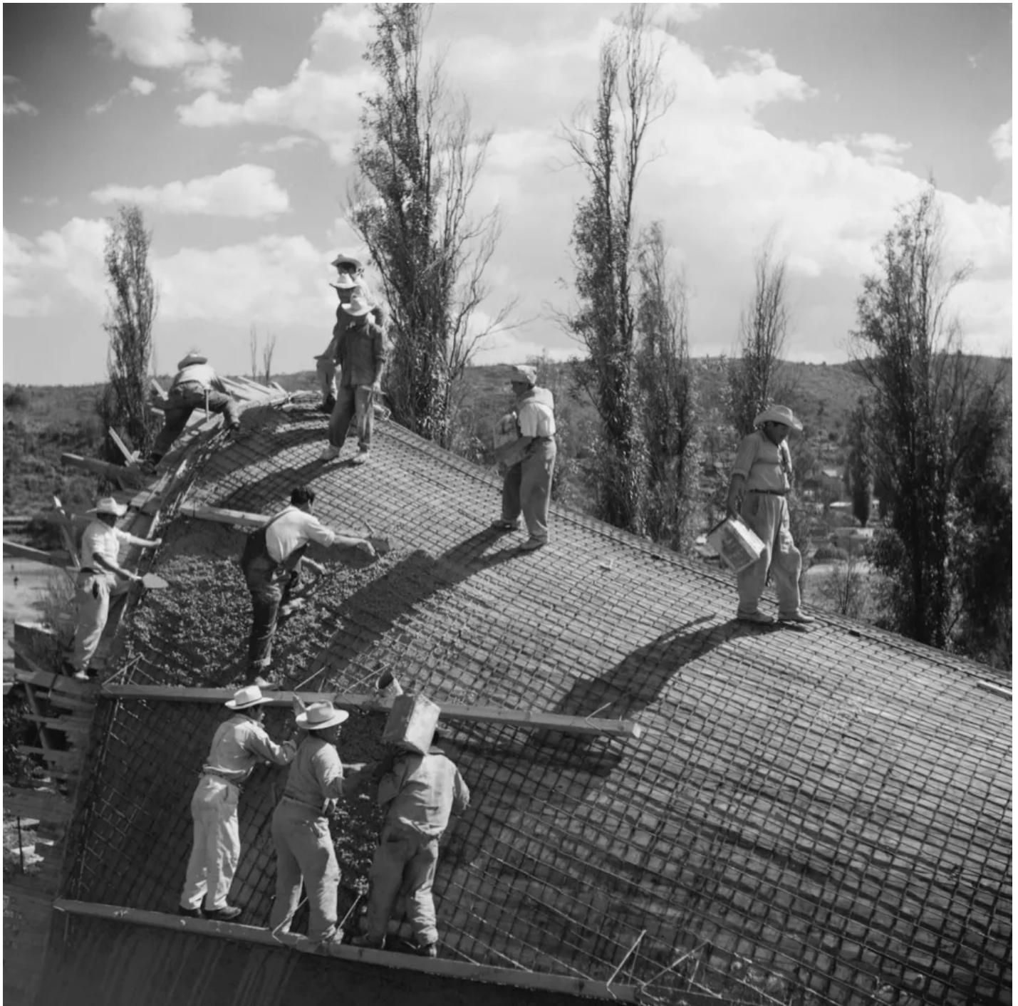
Workers arrange the scaffolding for Los Manantiales | Juan Guzmán, from the Archivo Fundación Televisa
